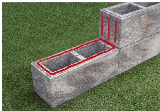
Бетон для заполнения полых камер должен быть изготовлен в соответствии с требованиями ГОСТ 7473 - 2010 с минимальным классом прочности B15 (M200). Консистенция бетона должна быть подобрана так, чтобы бетонная смесь поддавалась пластичным формам и укладывалась в пустотелые камеры. Кроме того, каждый раз, когда вы заливаете смесь, она должна сопровождаться уплотнением, вручную с помощью стержня или мастерка.
